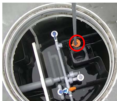
②エア管とオレンジ蓋を外します。
